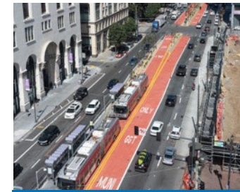
公共交通基礎設施
